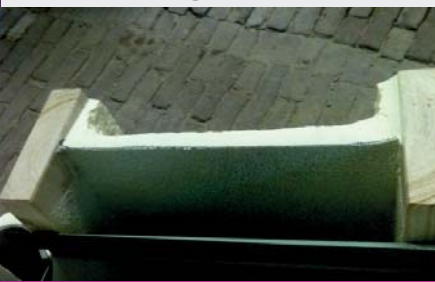
Sprühdämmung auf Dämmnetz Zwischen den Sparren
