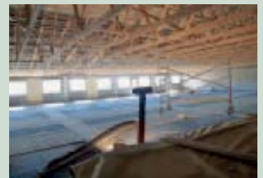
Der Aufzuchtstall auf dem Betrieb Kox wurde mit Isofekt Sprühschaum gedämmt.
